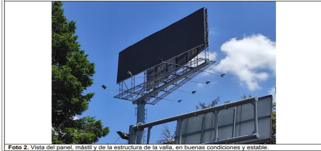
Foto 2. Vista del panel, mástil y de la estructura de la valla, en buenas condiciones y estable.
